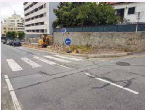
S. Cosme: construção de passeios na Avenida da Conduta
