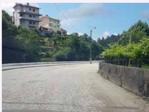
S. Pedro da Cova: requalificação da Rua do Ramalho
