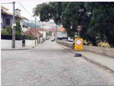
Fânzeres: requalificação da Rua de Cabanas - drenagem de águas pluviais, construção de novos passeios e repavimentação
