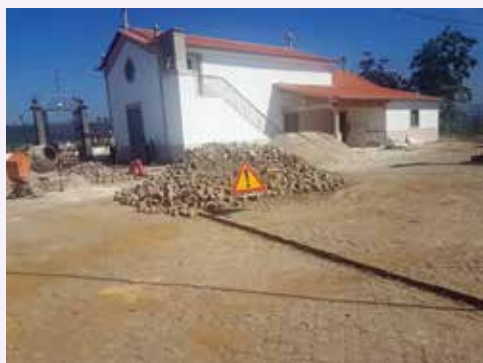
Foz do Sousa: obras de recuperação da capela, em Compostela
