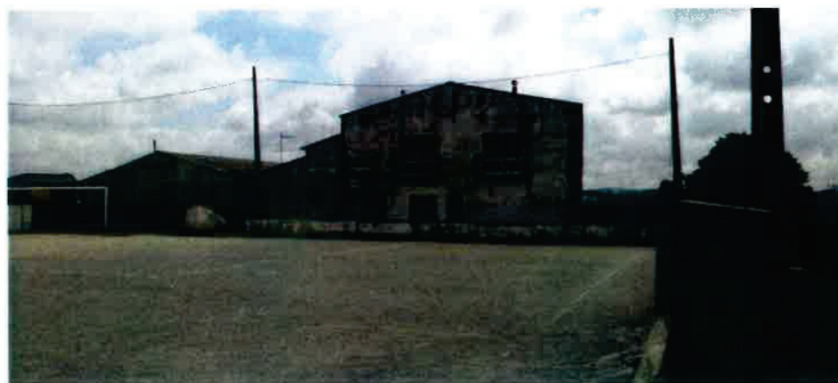
Foto 3 - Zona actual dos balneários e edifício sede a demolir
