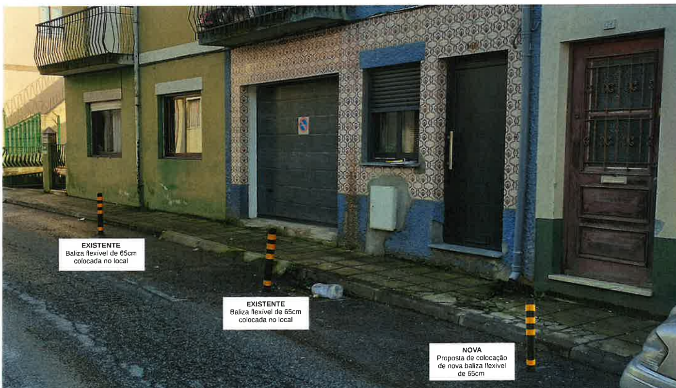
Colocação de baliza flexível de 65cm no alinhamento das existentes Vista no sentido ascendente
